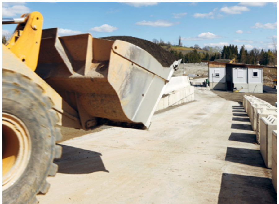
Die Walzbetonstrecke unter Schwerverkehrsbelastung
