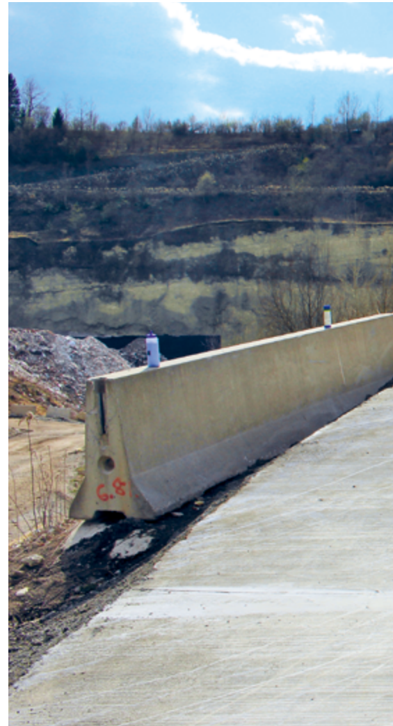
Ein fertiggestelltes Teilstück
