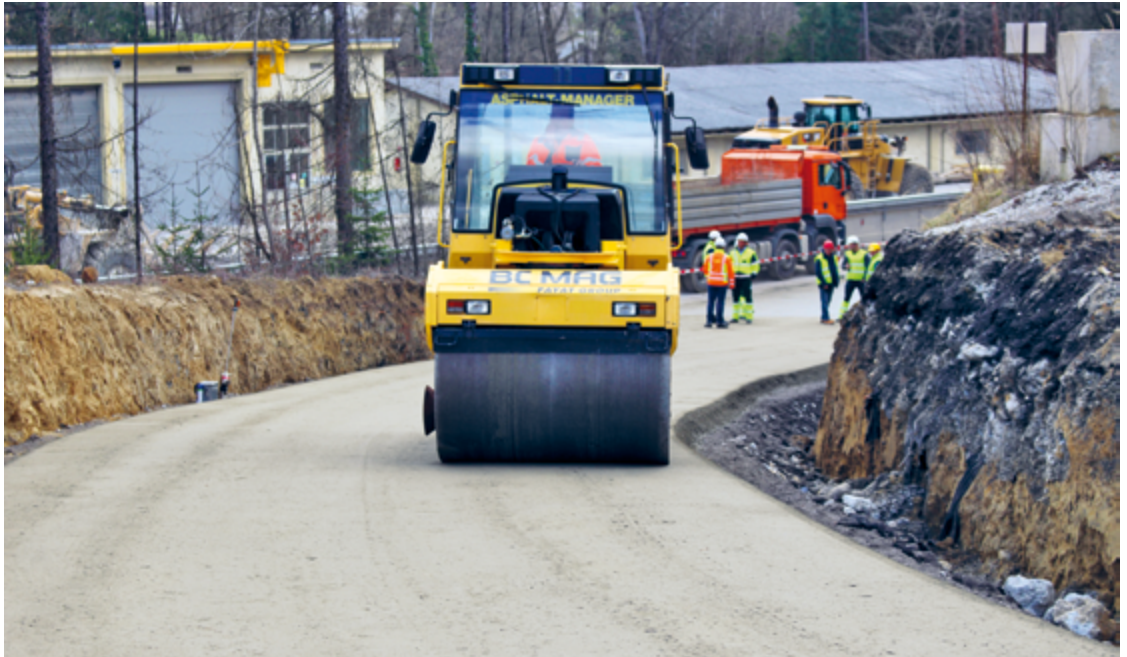
Der Walzbetoneinbau ist auch in Kurven und auf Strecken mit Steigung möglich.
