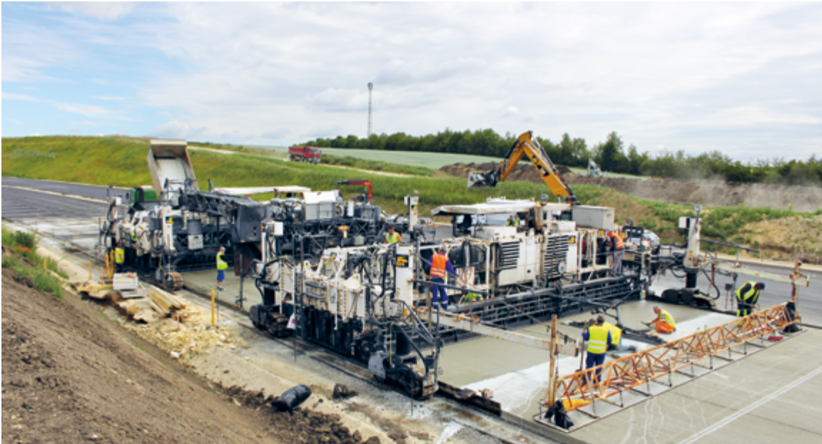
Einbau mit einem Gleitschalungsfertiger auf der Autobahn: Für den Einbau auf Landstraßen mit Gegenverkehr sind diese Geräte in der Regel zu breit.
