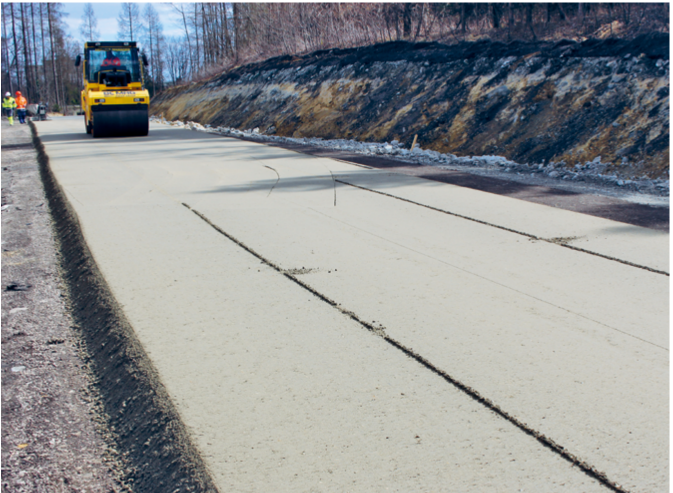
Nachverdichtung des Betons mit Glattmantelwalze: Die Stege im Vordergrund werden durch die Nachverdichtung noch geglättet.
