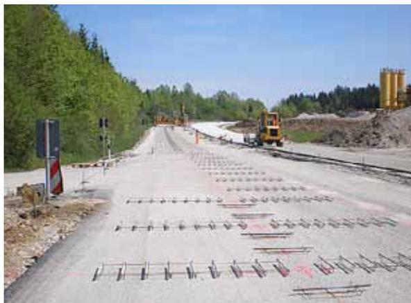
verlegte Dübel und Anker auf vorbereiteter Unterlage
