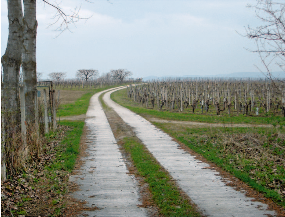
Abbildung 2: Betonspurweg Horitschon, Burgenland (Foto VÖZ)
