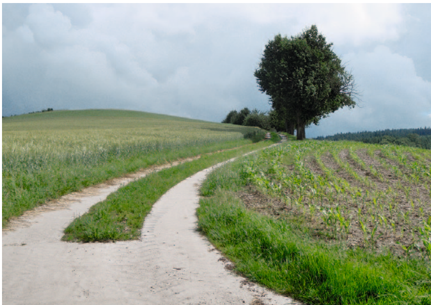
Abbildung 5: Fertiger, begrünter Betonspurweg «Dallinger», Oberösterreich (Foto VÖZ)
