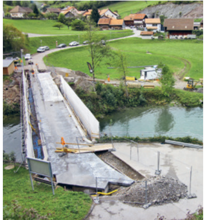
Abb. 8 Überblick Brücke in Montbovon während Instandsetzung
