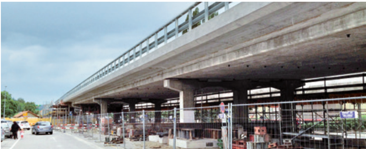
Abb. 11 Untersicht der instandgesetzten Randabschlüsse
