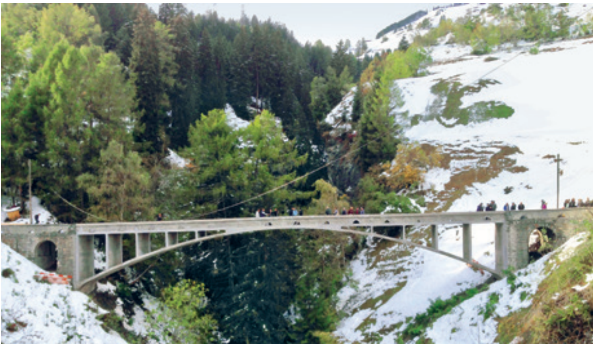
Abb. 7 Brücke nach der sanften Instandsetzung
