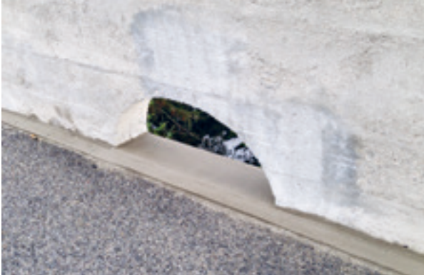
Abb. 6 Detail zur Oberflächenausbildung mit eingestreutem Splitt
