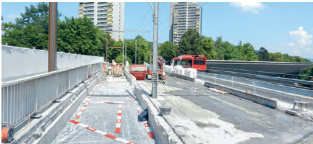
Abb. 12 Blick auf die für die Beschichtung vorbereitete Fahrbahnhälfte
