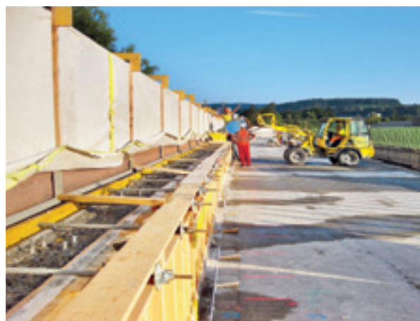
Abb. 4 Vorbereitete Schalung für die Beschichtung
