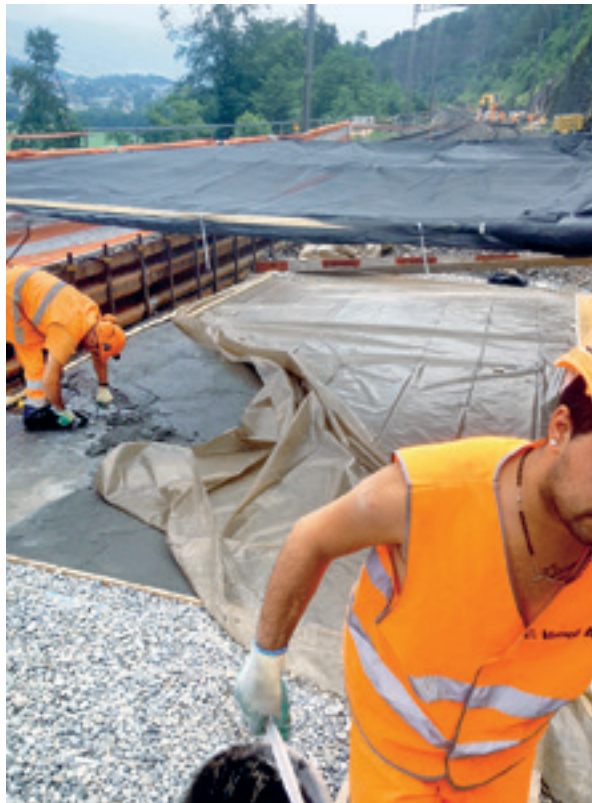
Abb. 2 Abdecken des UHFB unverzüglich nach dem Einbau, Sonnenschutzdach
